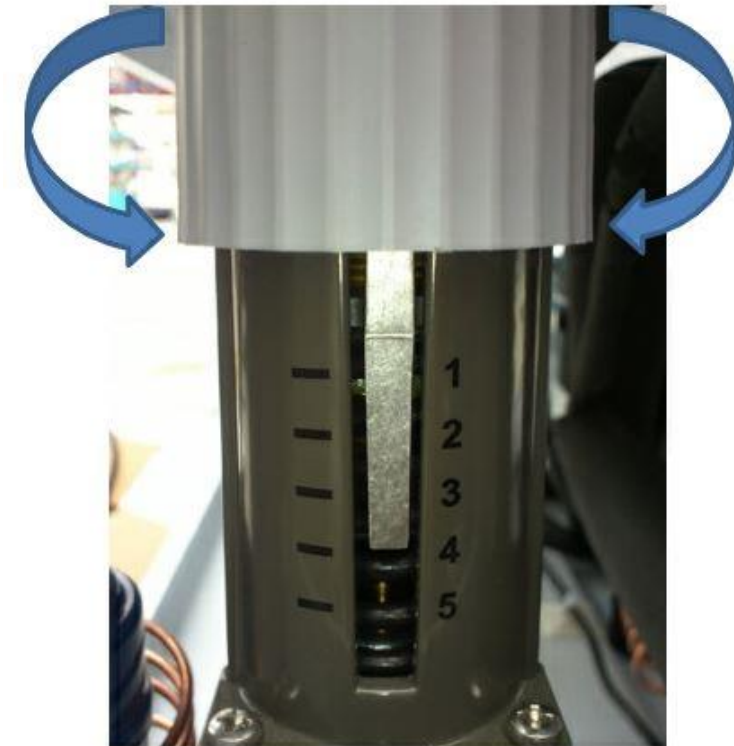
Bild 3 Durch Drehen des Einstellrades in Richtung 1 auf der Skala wird die Kühlwassermenge erhöht und durch Drehen in Richtung 5 auf der Skala wird die Kühlwassermenge reduziert.
